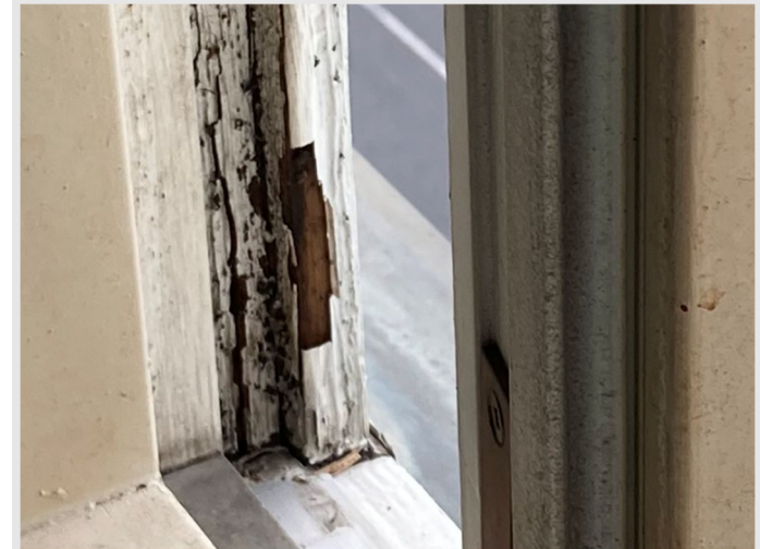
Vindue i gadefacade med påbegyndt nedbrydning.
