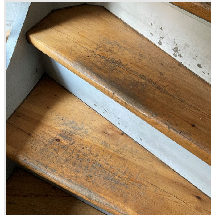
Bitrappe til kælder, hvor lak på trinoverflader er slidt væk.
