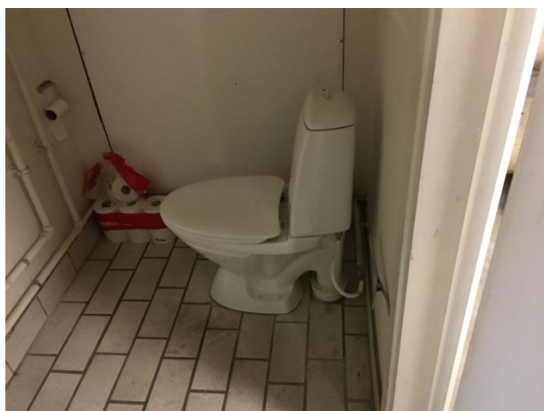
Fælles toilet i kælder.
