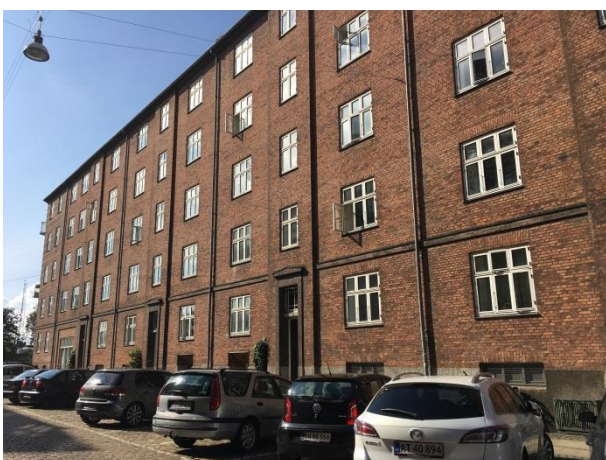
Gadefacade mod Knud Lavards Gade
