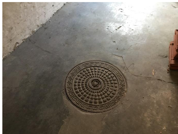
Kloakdæksel i kælder
