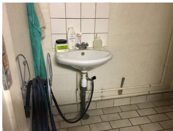
Fælles toilet i kælder.
