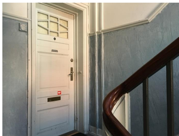
Opgangsdøre på hovedtrapper.
