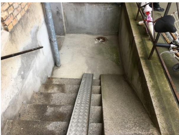
Nedgang til kælder.
