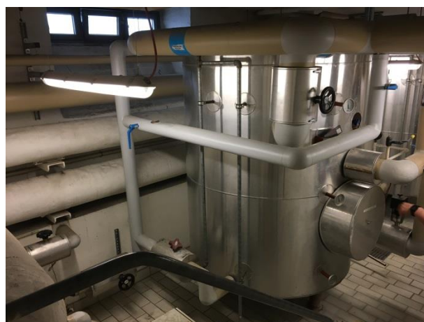
Varmtvandsbeholder.
