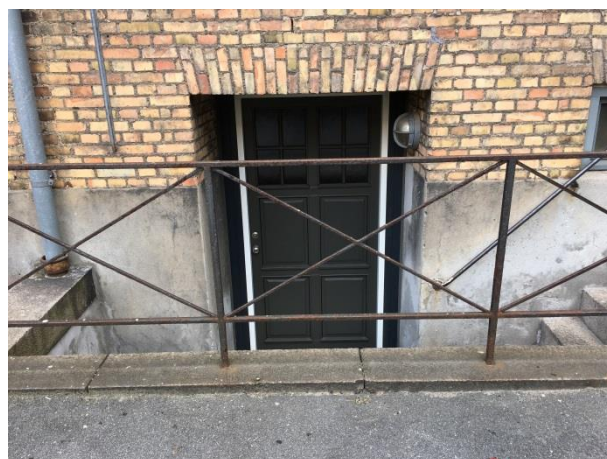
Kælderdør mod gården.
