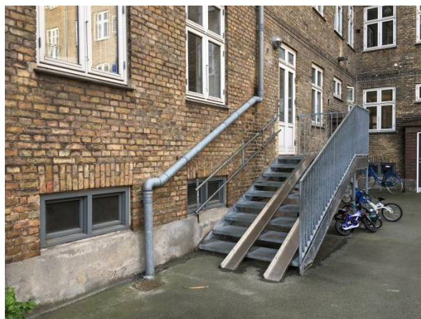
Ståltrappe til institution.
