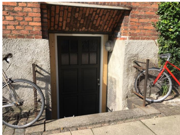
Kælderdør mod gade.
